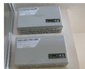
モジュール設置
